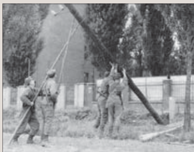
Výstavba telefonního vedení / Installation of a telephone line
