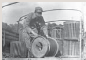
Nakládání kabelu NK-12 / Loading of NK-12 cable
