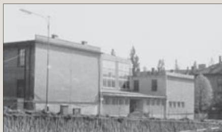
Výstavba kuchyňského bloku / Development of a kitchen block
