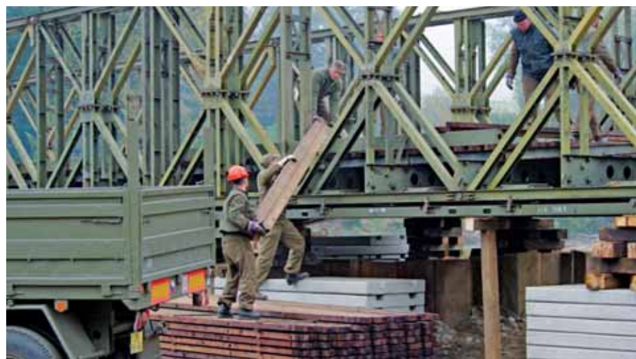
Ke stavbě konstrukce jsou také potřeba metry a metry dřeva.
