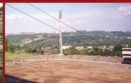
Rekonstrukce stadionu. Foto: Archiv ASC DUKLA, 2002
